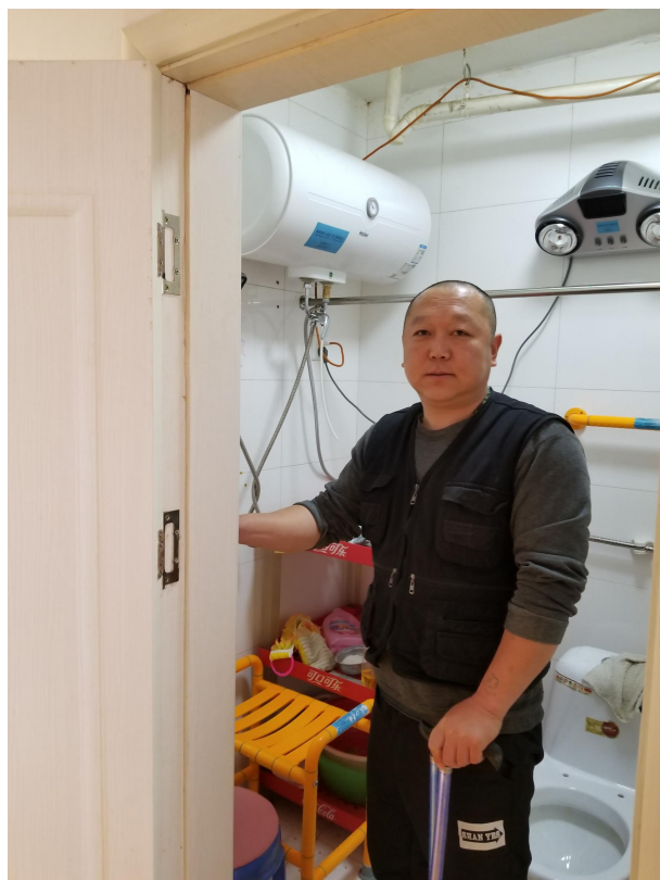
为项目受助残疾人安装电热水器、浴霸和无障碍扶手、浴凳
