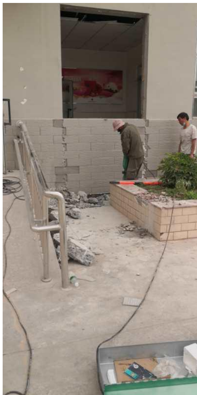
项目资助新疆库车特校安装无障碍电梯
