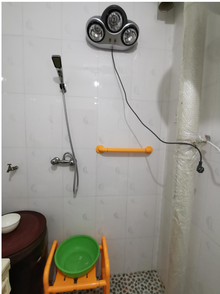
项目资助安装的浴霸、喷头、无障碍扶手和浴凳
